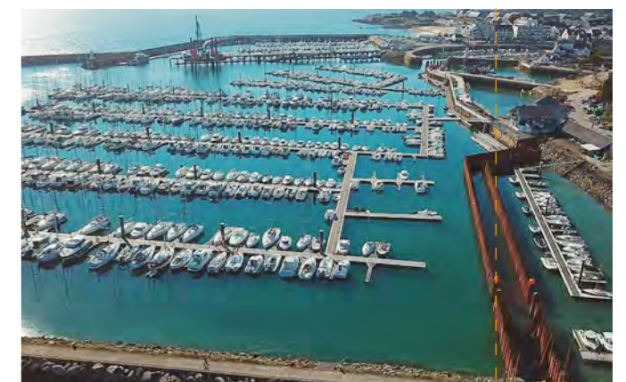
Fin juillet 2018 - Vue générale du bassin de Castéro.
